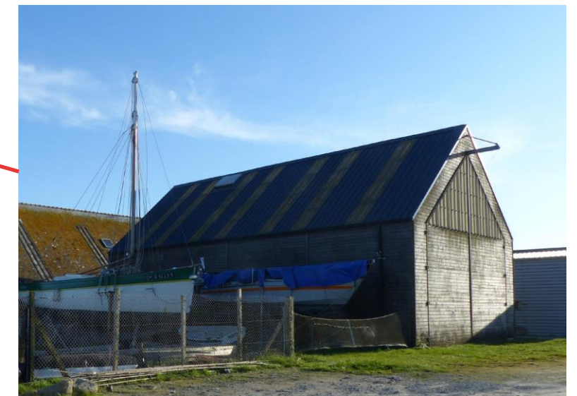
Bardage bois du chantier naval Vincent Sculler
