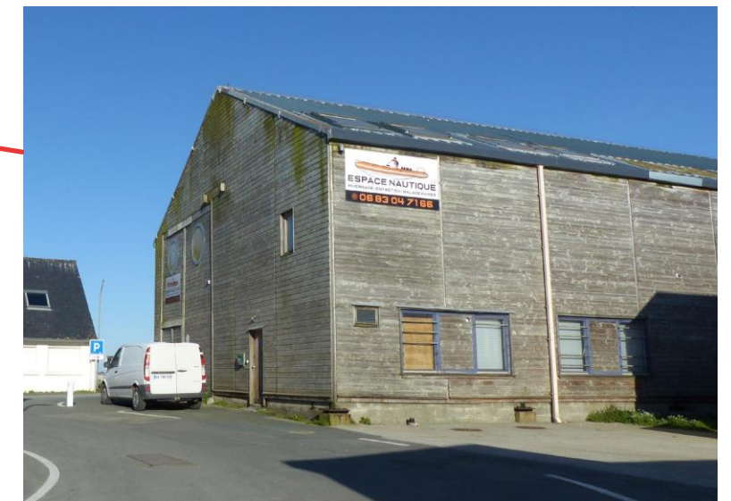
Bardage bois du bâtiment Espace Nautique 29
