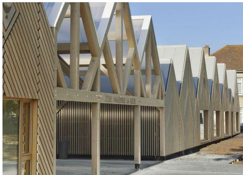
Linéaire commercial et halle couverte / Bardage bois
