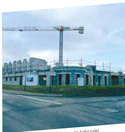
Le chantier de la maison médicale
